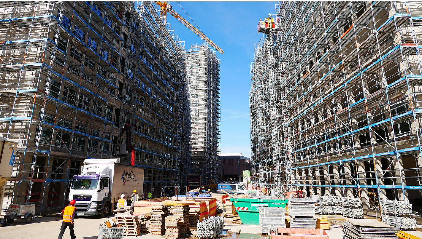
Die drei Zurich Gebäude der MesseCity Köln im Rohbau.
